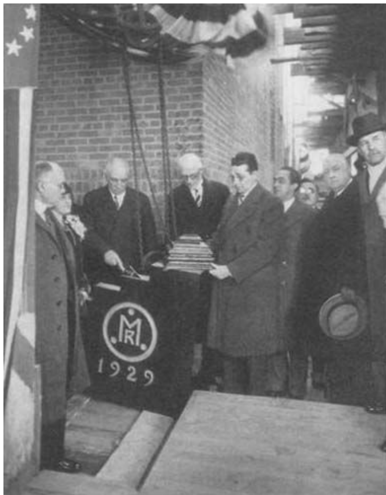
Установка закладного камня. Нью-Йорк, 1929. В центре Луис Хорш с ларцом
